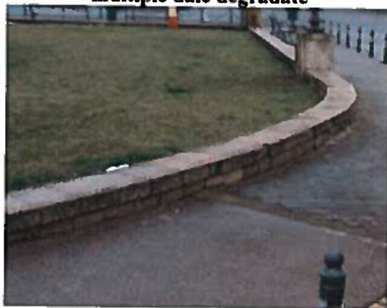
Foto 18. Detaliu element de încadrare a zonelor cu pavaj și delimitare zona verde
