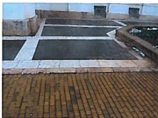
Foto 12. Pavele de klinker neomogene. Dale din marmură cu muchii rupte
